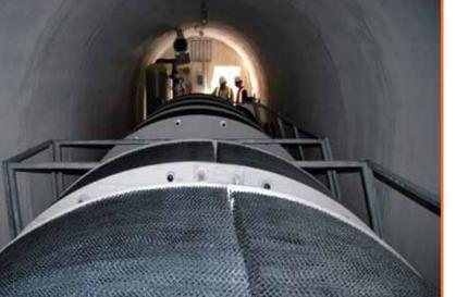
El agua tratada que proviene de la cuarta etapa del tanque RBC (Recator Biológico de Contacto) es conducida al tanque de sedimentación secundario.
